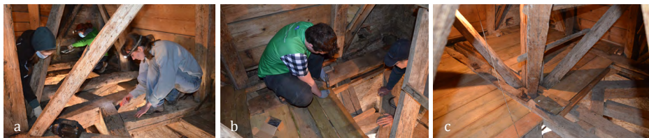
SLIKA 7. Po temeljitem očiščenju zvonika (a) smo se lotili izdelave lesenega podesta (b in c), ki bo preprečeval padanje gvana na zvonove (foto: Simon Zidar).
