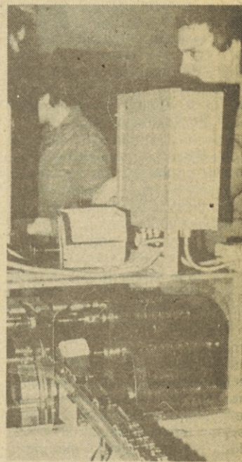
Delovna operacija montiranja tulca na baterijski člen
