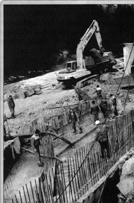
Gradbinci podjetja Ceste mostovi Celje hitijo z izgradnjo mostu med Lučami in Iglo (foto: Jože Miklavc)
