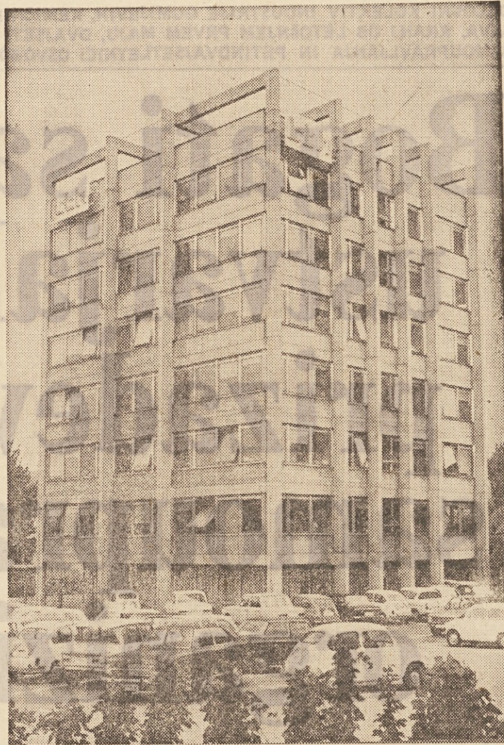
Upravno poslopje Loške tovarne hladilnikov na Trati pri Škofji Loki
