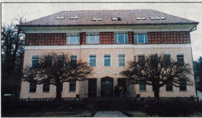
Prenovljena stavba Višje strokovne šole za gostinstvo in turizem Bled.
