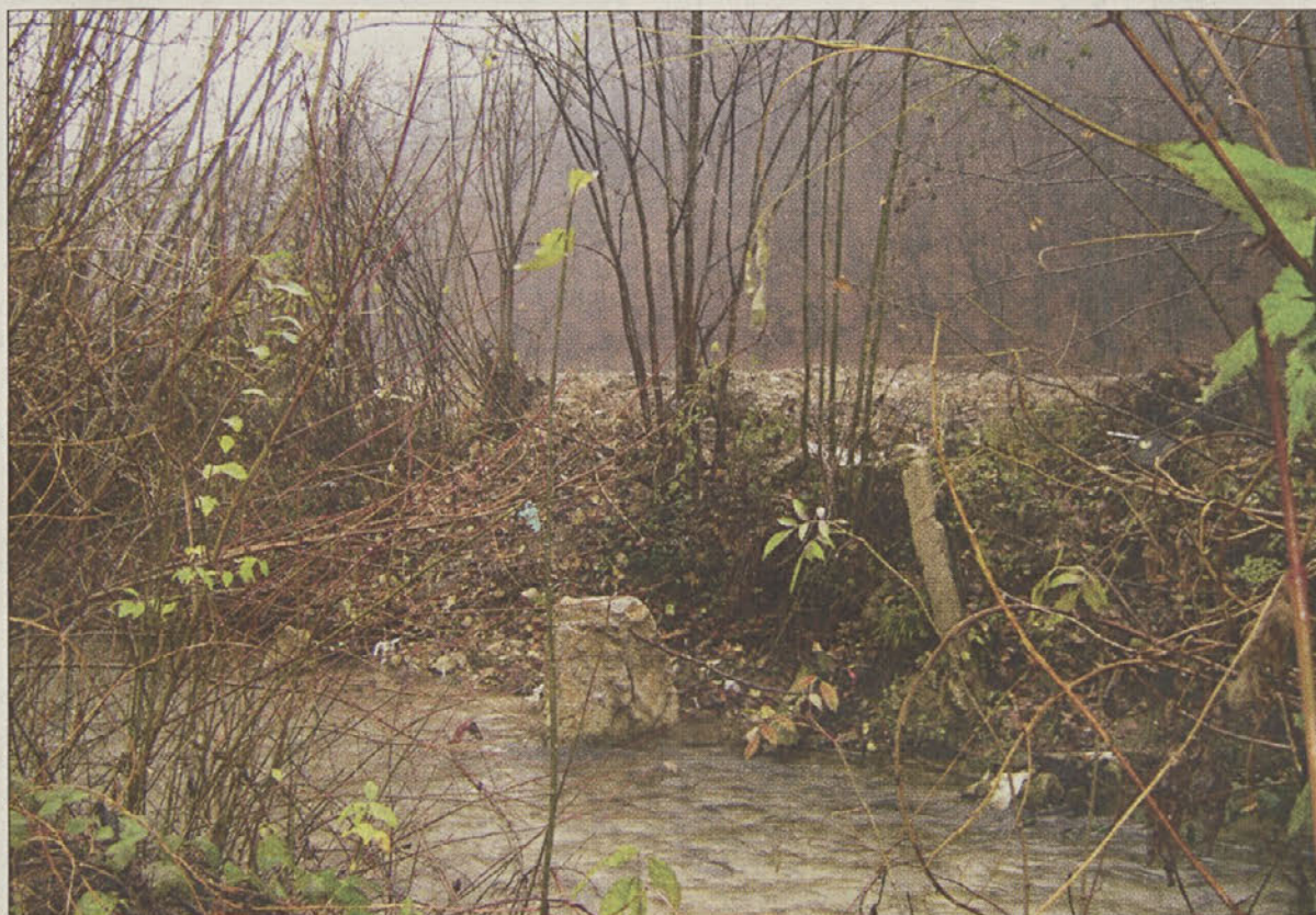
Hrvati so začeli z nasipavanjem brežine Breganščice, prebivalci v Slovenski vasi se bojijo poplav.
