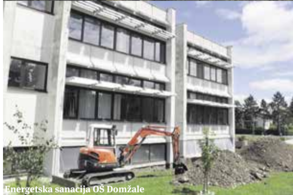
Energetska sanacija OŠ Domžale
