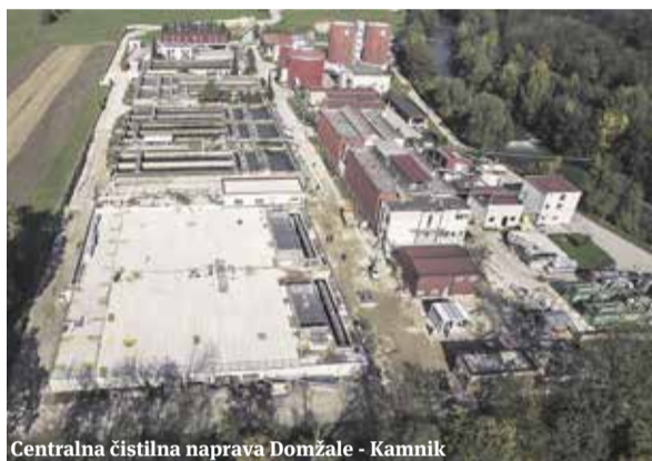
Centralna čistilna naprava Domžale - Kamnik
