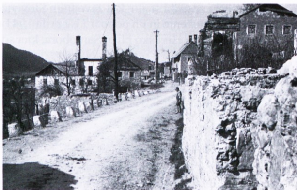
Ruševine hiš ob glavni cesti v vasi Travnik v po italijanski ofenzivi na Notranjskem julija 1942. Muzej novejšje zgodovine Slovenije (MNZS)
