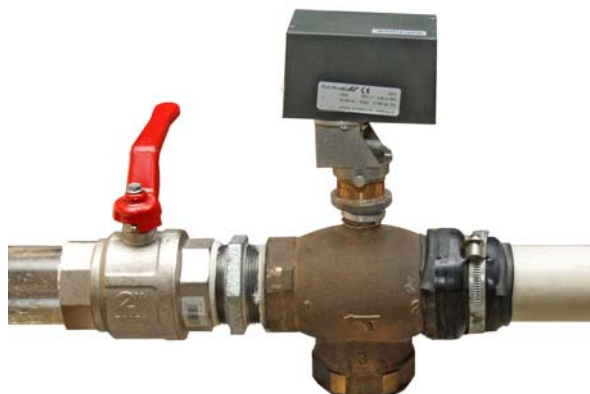
Slika 5.7: Regulacijski ventil z elektromotorjem in zaporni kroglični ventil
