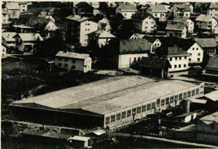
Novo proizvodno halo so zgradili tudi v Alpini.
