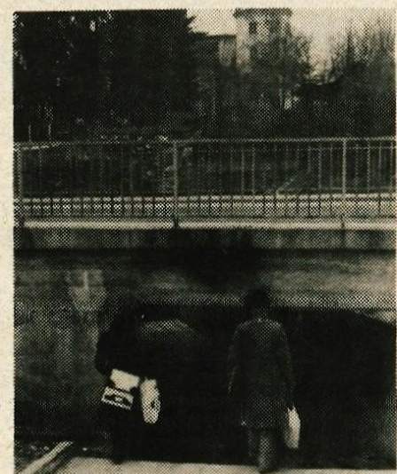
Škofja Loka - Pri osnovni šoli Podlubnik gradijo podhod, ki bo izrenega pomena predvsem za varnost šolarjev. Denar za gradnjo je prispevala krajevna skupnost Škofja Loka. (lb) - Foto: F. Perdan
