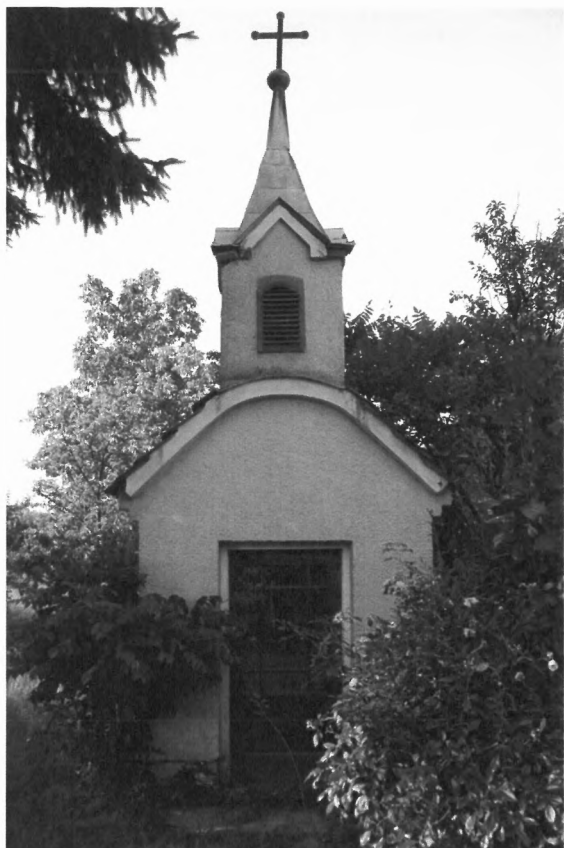
kapelica pri Orešnikovih
