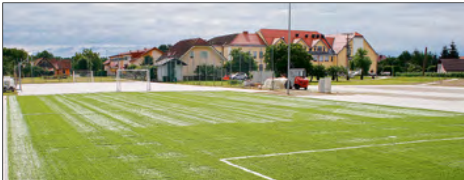
V okolici hajdinske šole je bilo še pred zaključkom šolskega leta gradbišče. Tam namreč poteka izgradnja športnih igrišč.
