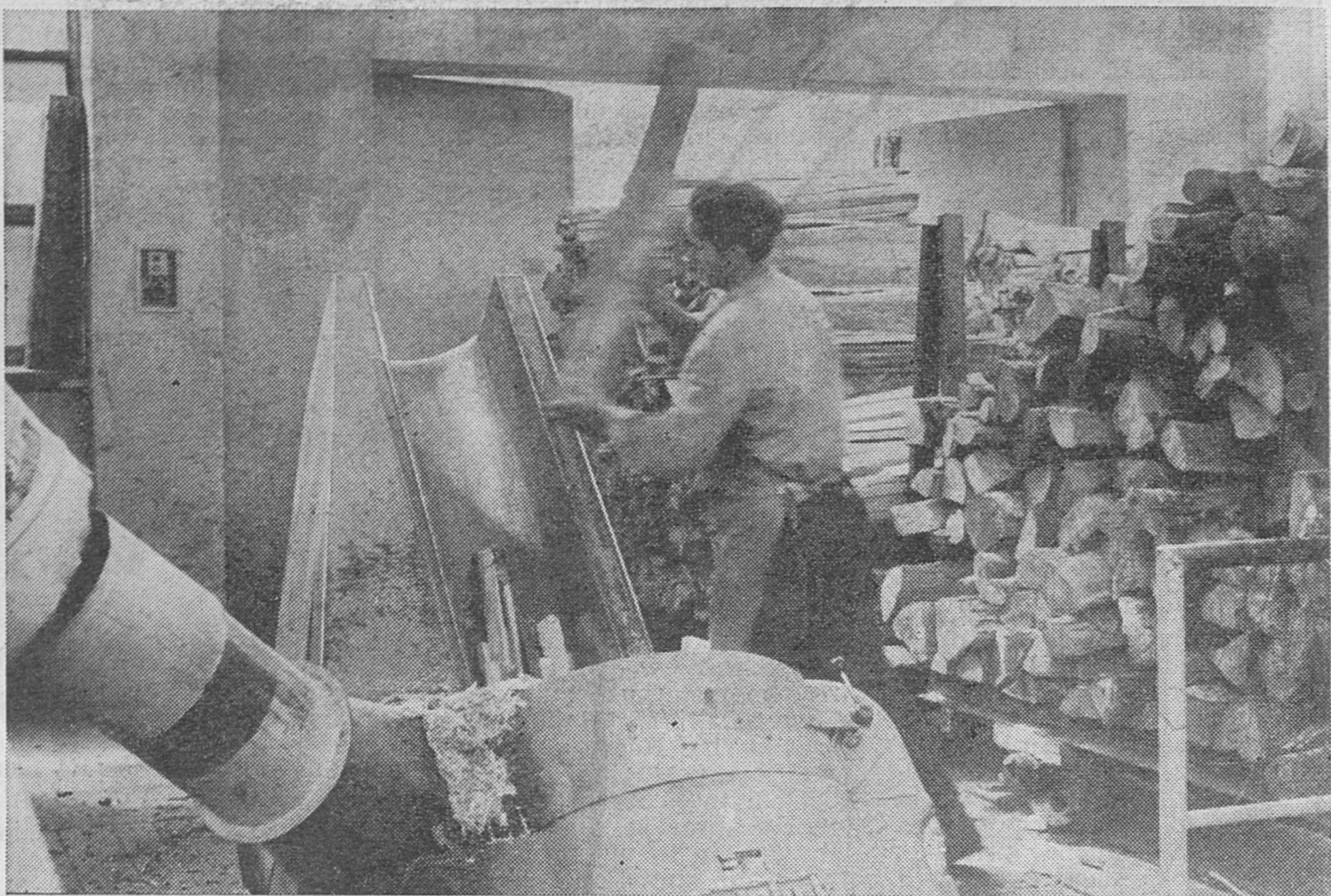
Tako se začne proizvodnja ivernih plošč. Stroj neprekinjeno požira surovino, ki smo jo včasih uporabljali za kurjavo, danes pa iz nje pridobivamo najkvalitetnejše ivernate plošče
