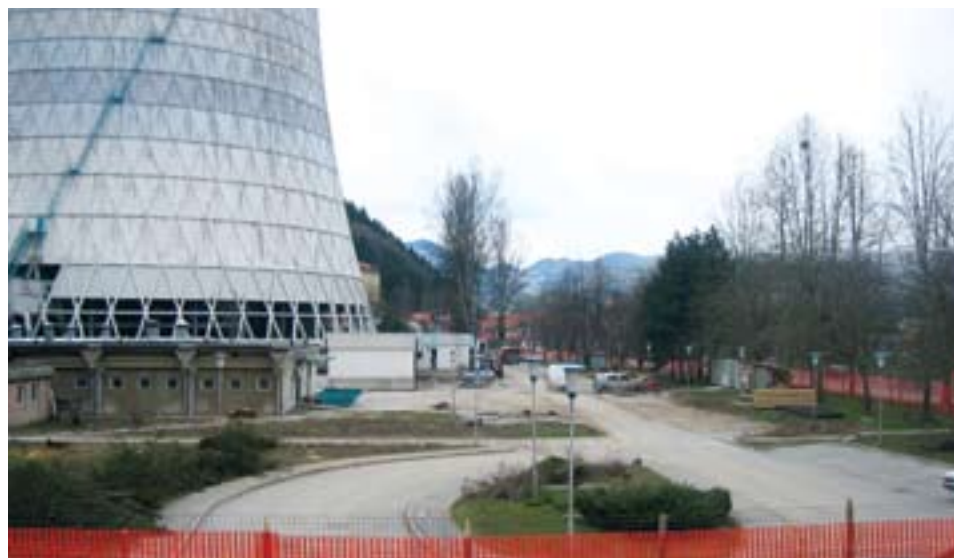
Telekomunikacijsko vozlišče elektroenergetskih sistemov Slovenije bo poslej locirano na tem območju termoelektrarne.
