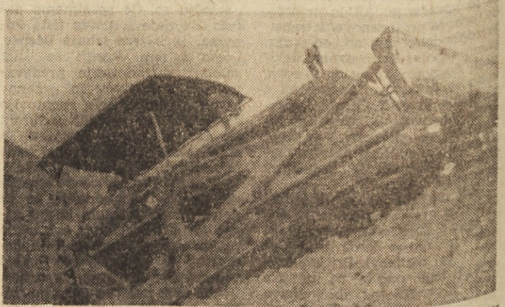
Ob novi stanovanjski stavbi podjetja Kamnik v Kamniku so začeli delati še samopostrežno trgovino. Buldozerji so v polnem »delovnem elanu«.
