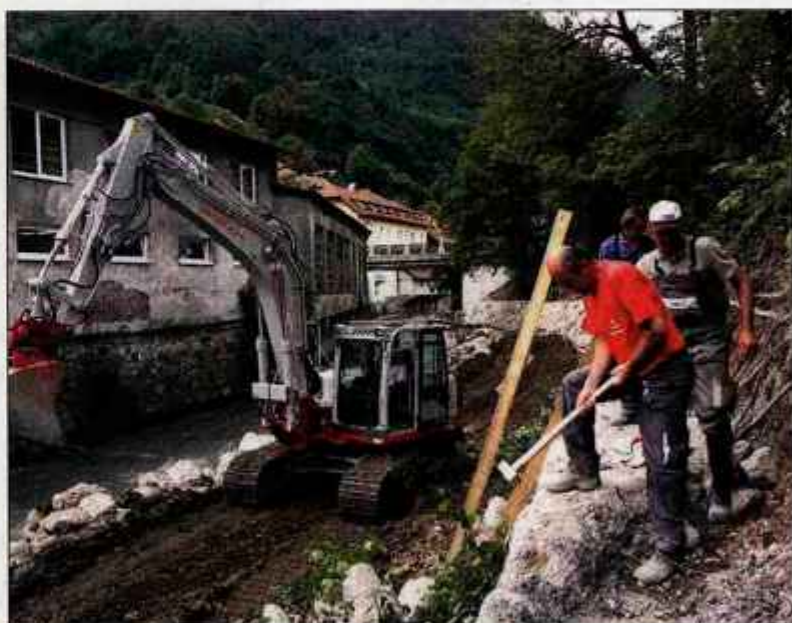
Brežino pod trziško šolo bodo utrdili z novim opornim zidom.
