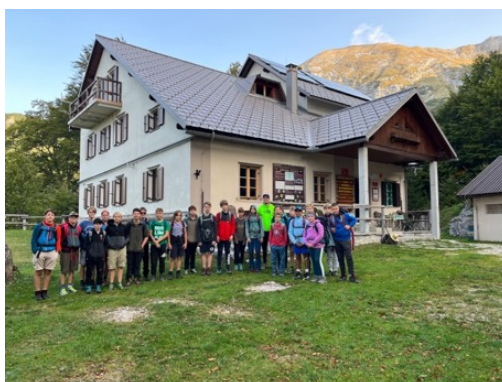
Slika 8: Koča na planini Razor, foto: Primož Trontelj
