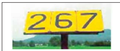
Slika 5. Videz markerja plinovodne trase (t. i. zračni marker)
