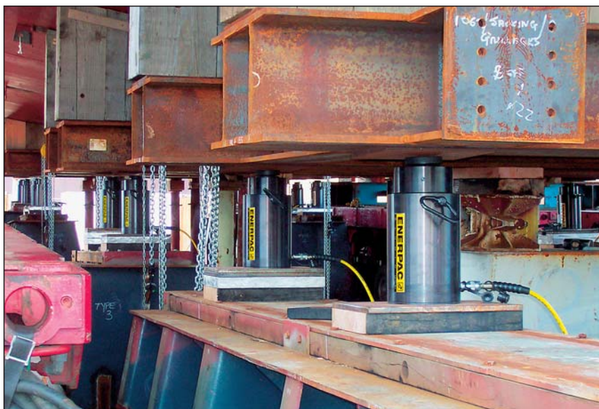
Slika 3. Osnovo integriranega hidravličnega sistema za dviganje predstavlja 16 enosmernih hidravličnih valjev
