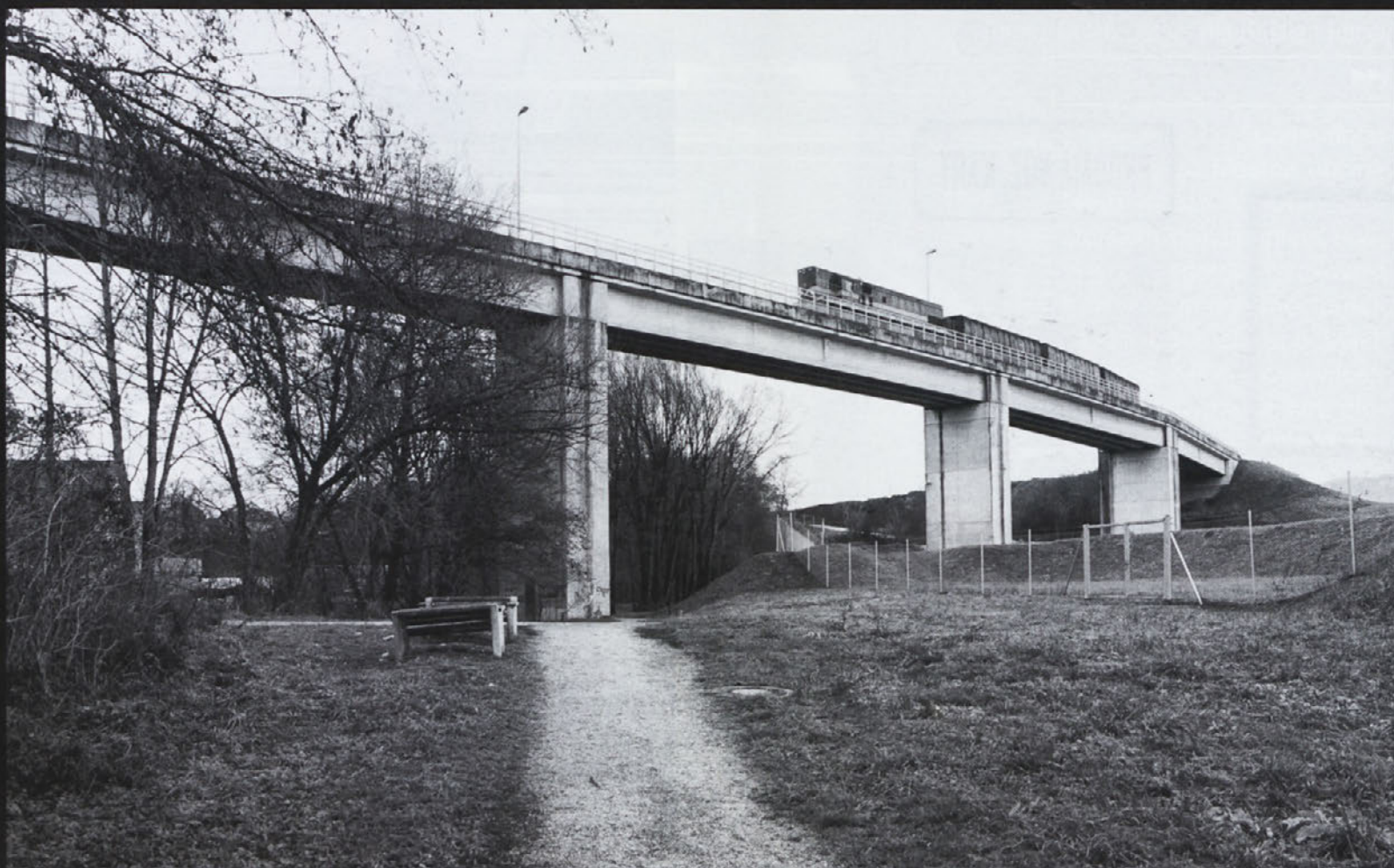
Železniški most do tovarne Revoz je s 575 metri najdaljši v železniškem omrežju v Sloveniji. Zgrajen je bil leta 1980 in predstavlja edini presežek, ki ga v železniški infrastrukturi predstavlja Dolenjska.
