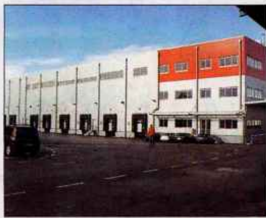
Novi logistični center Alpetourja Špedicije in transporta v Škofji Loki
