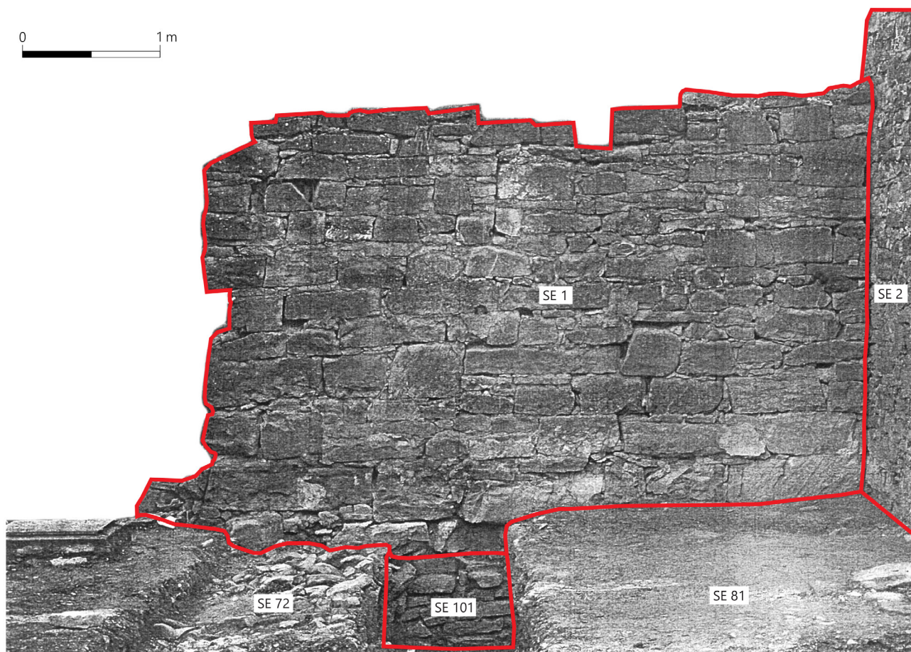
26 Zid SE 1, temelj SE 101, tlak SE 72 in nasutje SE 81 v južnem delu prostora 4.
