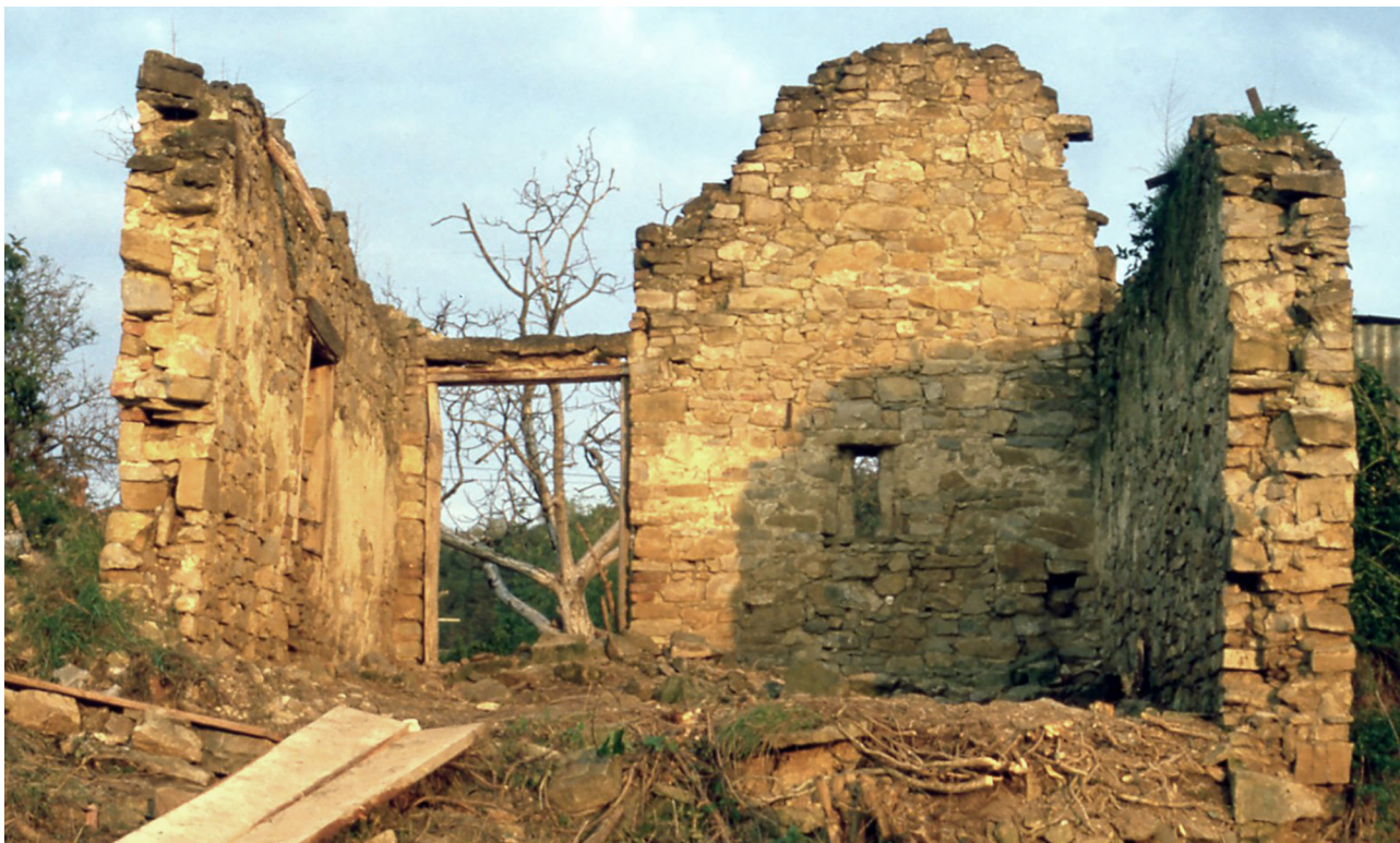
15 Pogled proti vzhodu na prostor 1 – južni prostor objekta.
