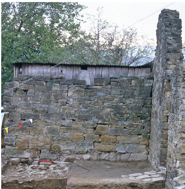
23 Pogled na južni del prostora 4 z zidom SE 1, zidom SE 2 in SE 3, vhodno rampo SE 70 ter tlakom SE 72.
