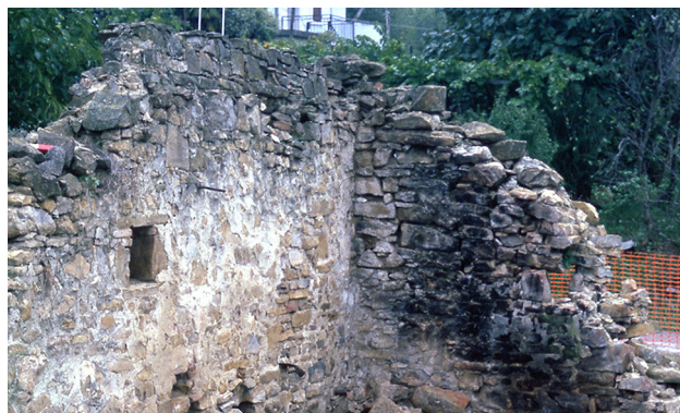
20 Severovzhodni del prostora 2 z zidom SE 4, zidno lino SE 94 ter njeno zazidavo SE 95 ter zidom SE 7 in zidno lino SE 97.
