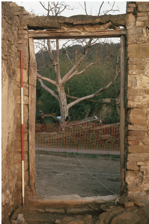
16 Vhod v prostor 1 SE 100 s kamnitim pragom SE 15, preklado SE 16 in lesenim okvirjem SE 102.
