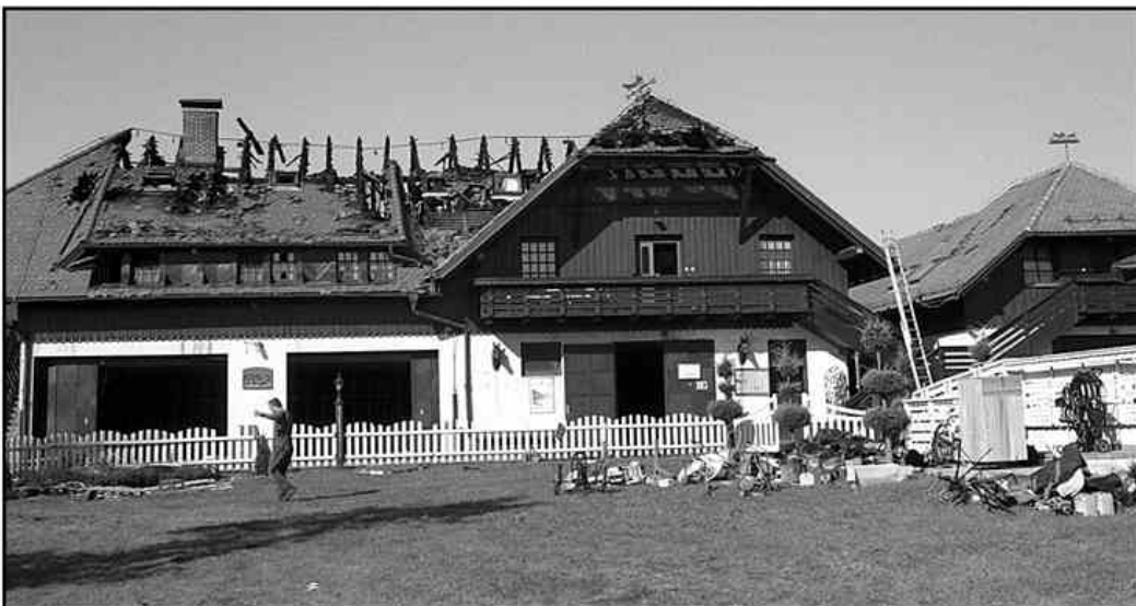
Ostreže čelnega dela poslopja je uničeno, žal tudi veliko stanovanje s tremi apartmaji in vso opremo
