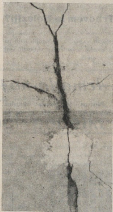
Razpoke na stenah v novih prulskih stolpičih pričajo o tem, kako so se načrtovalci uštelili glede trdnosti tal. Se homo pri njih kaj naučili?
