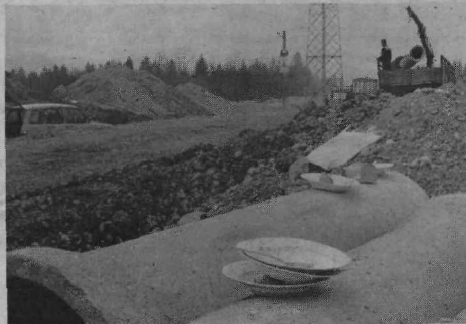
Zahodno od Titove ceste je že pripravljen izkop za bodočo severno obvoznico. Žal pa ne moremo zraven objaviti posnetke številnih delavcev, ki hite z gradnjo, zato smo med fotografiranjem s trase severne vpadnice izbrali tisto, ki najbolj ponazarja stanje na obvoznici. Počitek...
