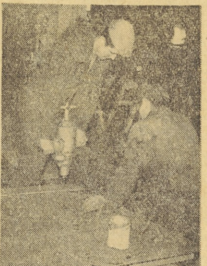
»Žičnica« Ljubljana — obrat Ribnica — montaža ogrodij strojev za preizkušnjo avtomobilskih zavor
