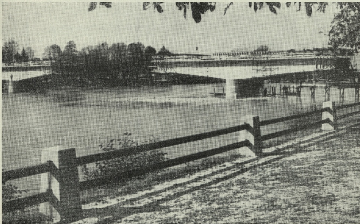
POGLED NA KONZOLE MED GRADNJO
