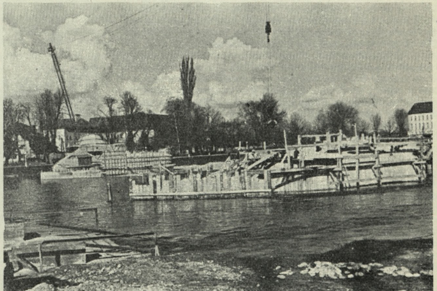
GRADNJA DESNEGA REČNEGA OPORNIKA POD ZAŠČITO LESENEGA ŠČITA; REČNI OPORNIK PRED RAZOPAŽENJEM
