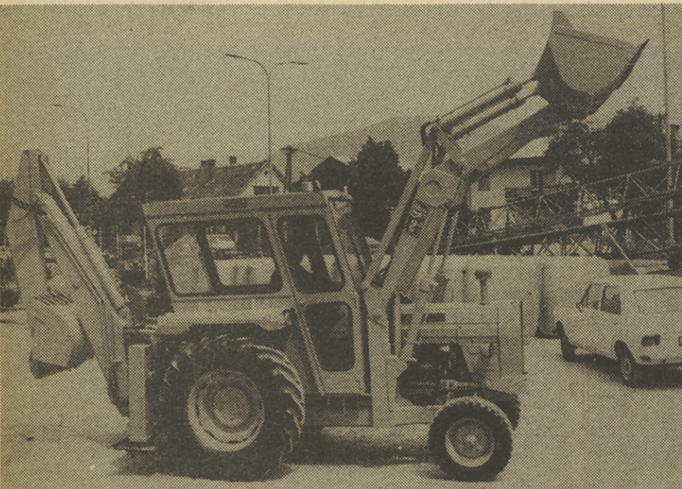
Steti BN-77. V TOZD Skip so izdelali steti bager nakladalec. Proizvodnjo so začeli leta 1977. Povpraševanje po teh strojih je na tržišču veliko, saj smo jih doslej uvažali. Skipov je v celoti narejen v Jugoslaviji.
