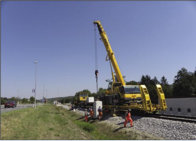
Postavljanje temeljev za elektrifikacijo proge proti Hodošu
