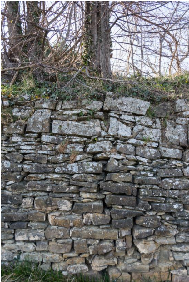
Slika 54: Zaraščena antropogena terasa, podprta s suhozidom, ki je pred porušenjem zaradi delovanja korenin, Pobegi, Koper (foto: B. Vrščaj)
