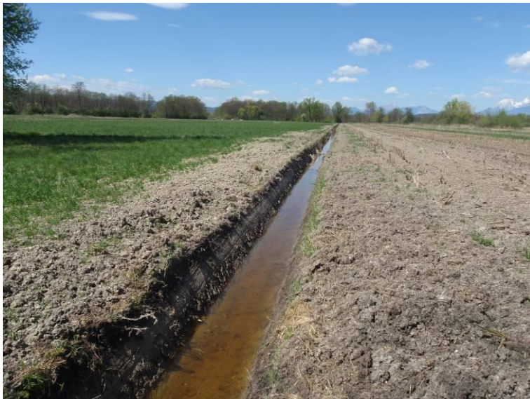
Slika 116: Novo poglobljeni hidromelioracijski jarek na Ljubljanskem barju brez vegetacije (foto: L. Pačnik)
