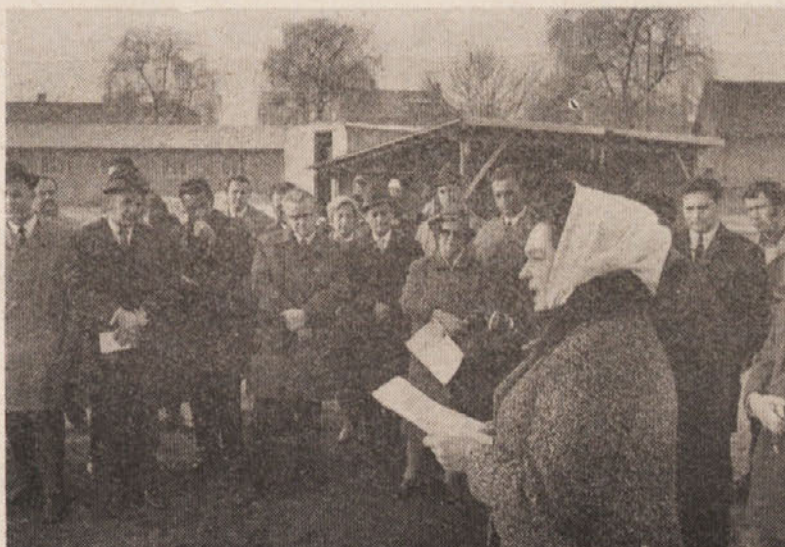
Direktorica posebne šole »Ivanke Uranjek« prof. Darinka Bizjakova pozdravlja začetek gradnje novega šolskega poslopja
