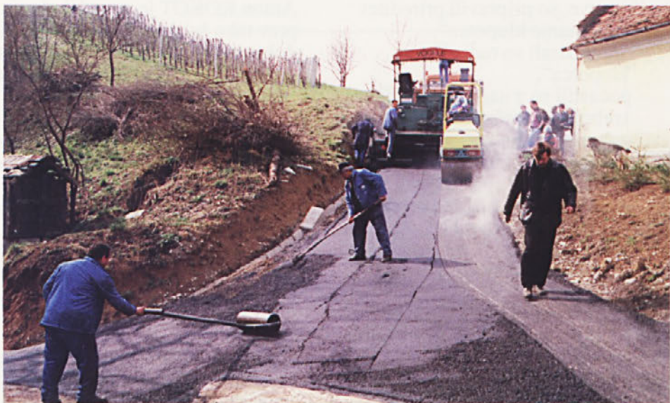
Asfaltiranje ceste pri Štuhečevi kapeli v Gradiščah.
