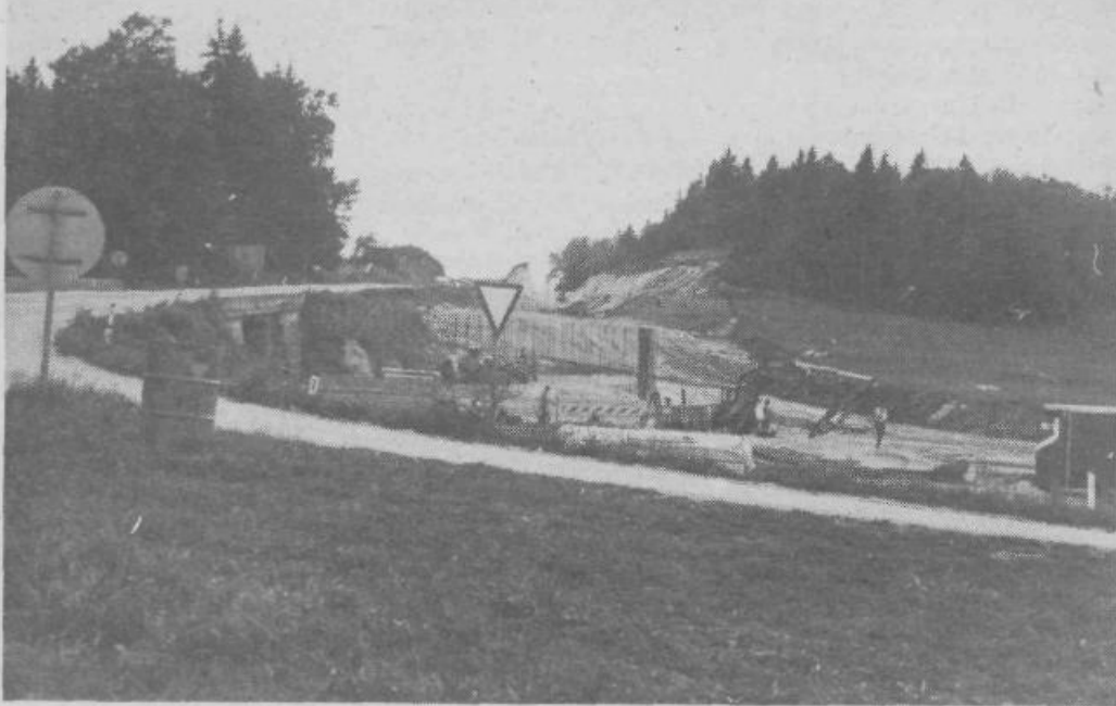
Dela potekajo po načrtih, žal pa je promet zaradi izvajanja del velikokrat oviran (foto: L. Rozman)
