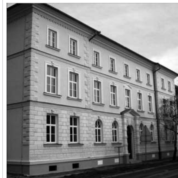
Nova podoba stavbe Kmetijske zadruge Ormož (foto arhiv občine)
