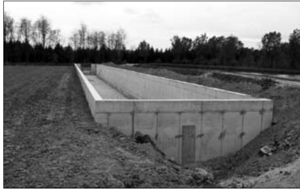
Slika 3: Izgradnja infiltracijskega polja 1. V II. zaključni fazi umetnega bogatnega podtalnice so se izvedla štiri infiltracijska polja 1, 3, 4 in 5. Polje 2 je bilo izvedeno že v prejšnji fazi bogatnega podtalnice.
