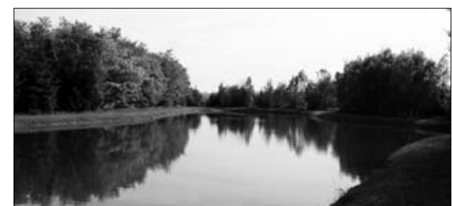
Slika 2: Zemljski bazen – usedalnik; v sklopu umetnega bogatjenja podtalnice so bili zgrajeni trije usedalniki.
