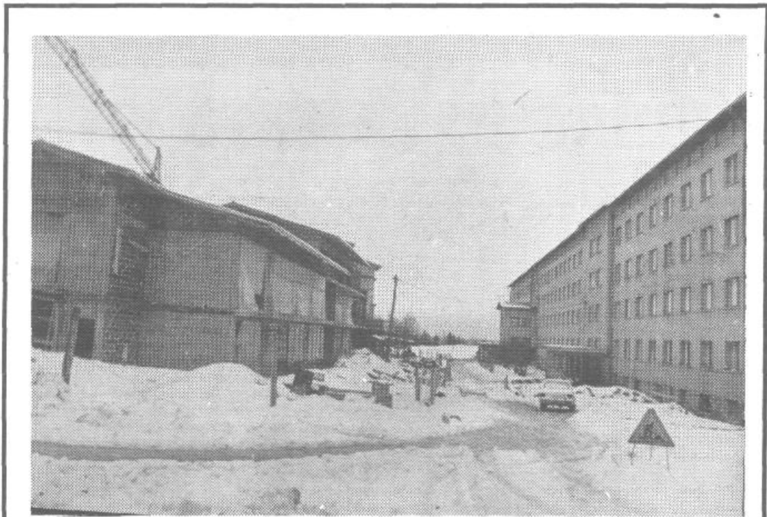
Ob občinskem prazniku lani so položili temeljni kamen za gradnjo doma za starejše občane na Bokalcih. Na sliki: gradnja dobro napreduje. Dom je že pod streho. Posnetek je bil napravljen pred dobrim mesecem dni
