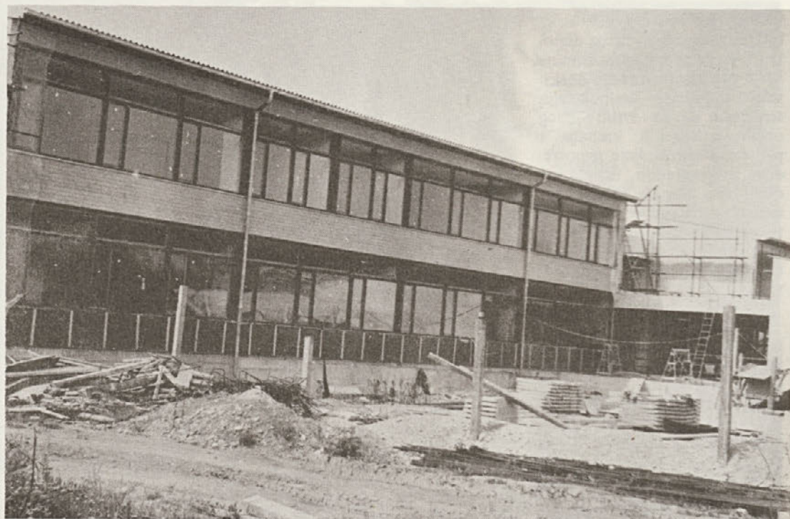
Gradilište Osnovne škole u stambenom naselju BS-3 u Ljubljani pokazuje svoje prave dimenzije tek sa dvorišne strane.
