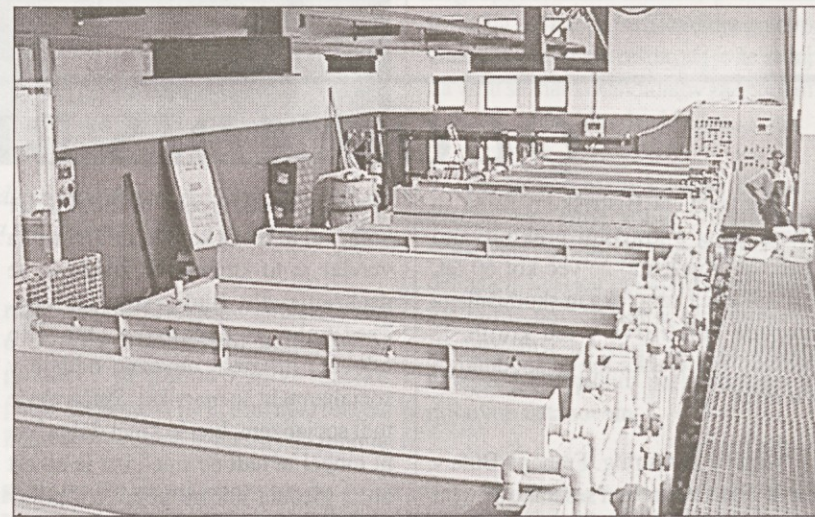
Ena izmed galvanskih linij v predmontaži v lastni hali v Plamingu
