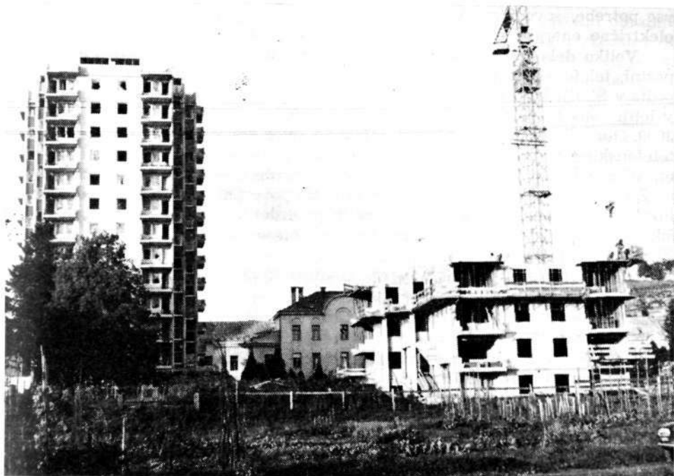
Gradnja stanovanjskih stolpnice ob Partizanski cesti v Škofji Loki. (Fototeka SGP Tehnik, Škofja Loka.)
