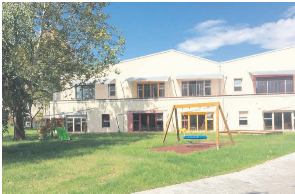
Vsa dela v novem vrtcu na Hudinji so bila opravljena skladno s terminskim načrtom in malčke bo po uradnem odprtju vrtca pričakalo tudi novo otroško igrišče ter lepo urejena okolica.
