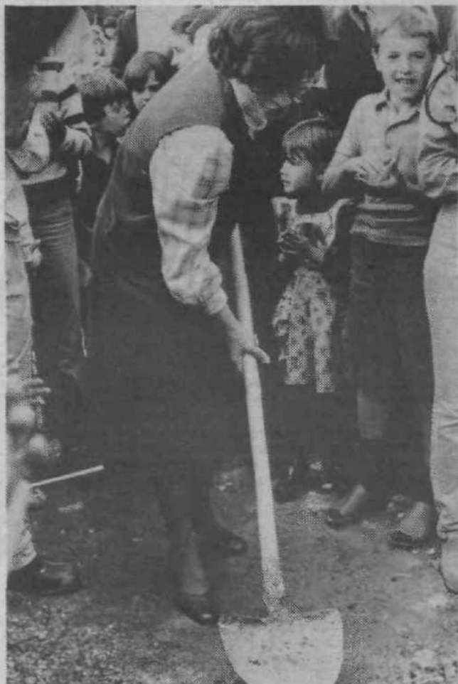
V KS Ivan Kevčič so položili temeljni kamen za novo šolo, ki bo zgrajena iz drugega samoprispevka.
