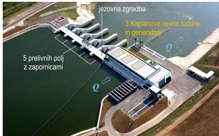
Slika 3: HE Boštanj na spodnji Savi ( \Delta h = 8,2 m, P_n = 32,5 MW).
