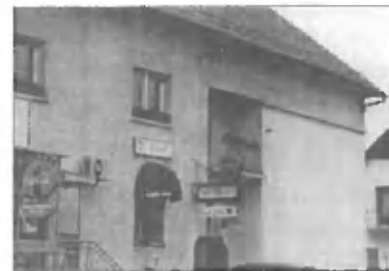
Občinska zgradba v Trzinu pa je izgledala ob prazniku tako, kol kaže priložena fotografija, posneta 8. 2. 2000 ob 11. uri.
