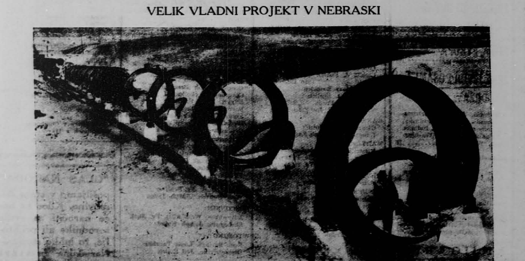
Slika nam predstavlja ogromne cevi za novo hidro-električno centralo v Nebraski. Za dva rezervarja in za 75 milj dolgi vodovod bo izdanih $7,500,000.
