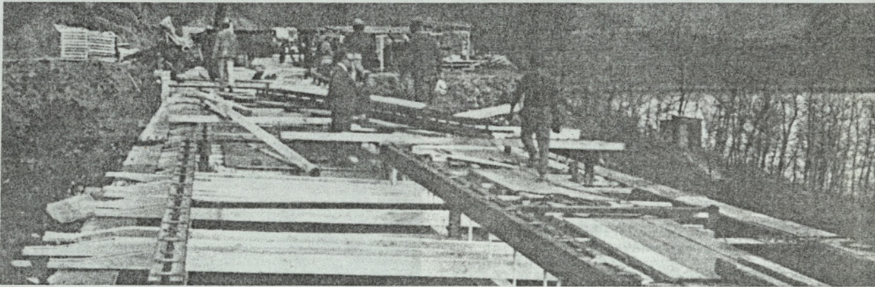
Slika 9. Zamenjava poškodovane voziščne plošče na sovprežnih cestnih mostovih.
