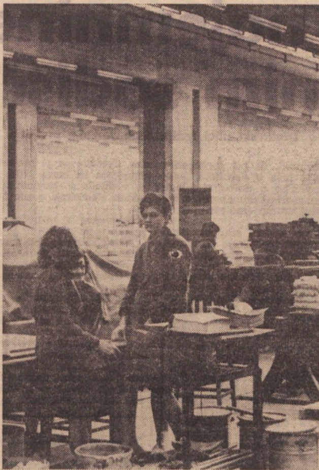
V NOVI »EMKI« ZE DELAJO — Čeprav novo poslopje še na zunanji ni povsem gotovo, so del prostora že uspeli opremiti za proizvodnjo. V eni izmed dvoran dela knjigoveznica. Novi prostori so moderno in lepo urejeni.
