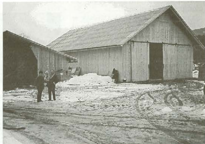
Obnovljeni gospodarski poslopji
