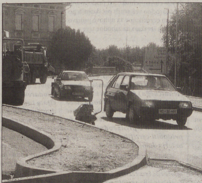
Z rekonstrukcijo ceste Vučja vas-Križevci občinsko središče izgublja svojo podobo, dela pa ne potekajo tako, kot zahtevajo občani. Foto: NJ
