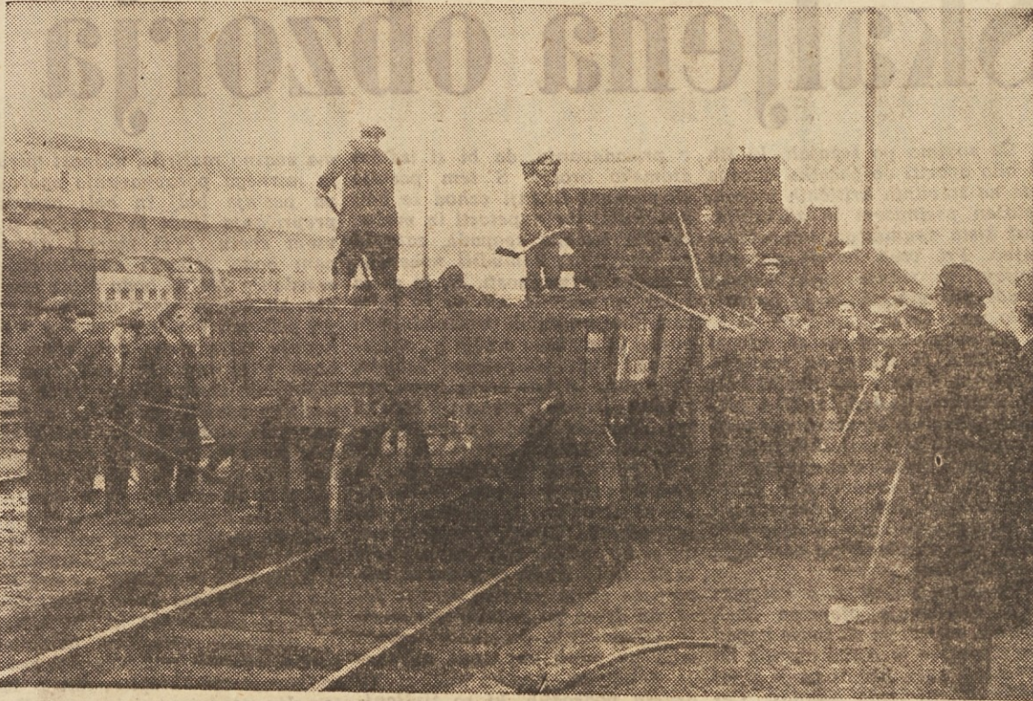
Na ljubljanski železniški postaji nasipavajo med tire nov tolčenec, ker je stari že dobredno razpadel. Tolčenec dovažajo z Verda, nazaj, v Preserje, pa odvažajo stari material, ki ga sproti odstranjujejo. V Preserju grade nasip za novo progo
