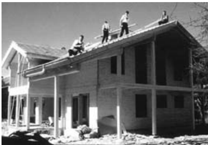
Slika 18: prefabricirana hiša, 3. faza
