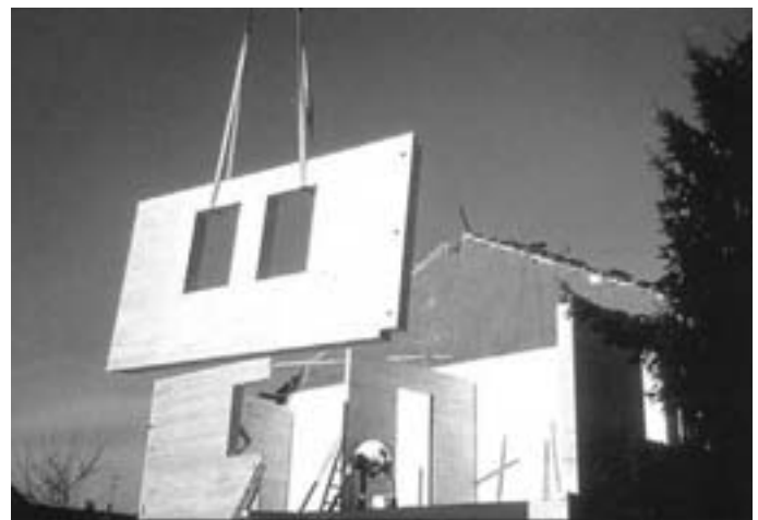
Slika 17: prefabricirana hiša RIKO, 1. faza
