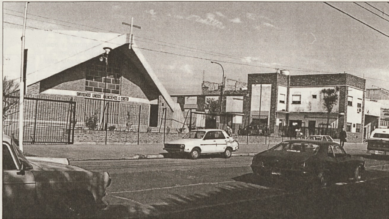
Farna cerkev z župniščem, ki ju je zgradil poleg farne dvorane in šolskih prostorov za vrtec in osnovno šolo župnik Janez Langus v Išidro Casanovi.
