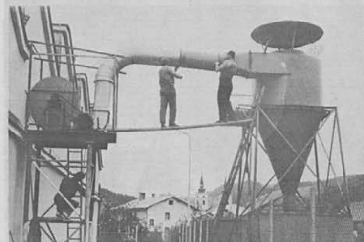
Janez Seljak in Valentin Poljanšek sta postavljala centralno odsesevalno napravo
